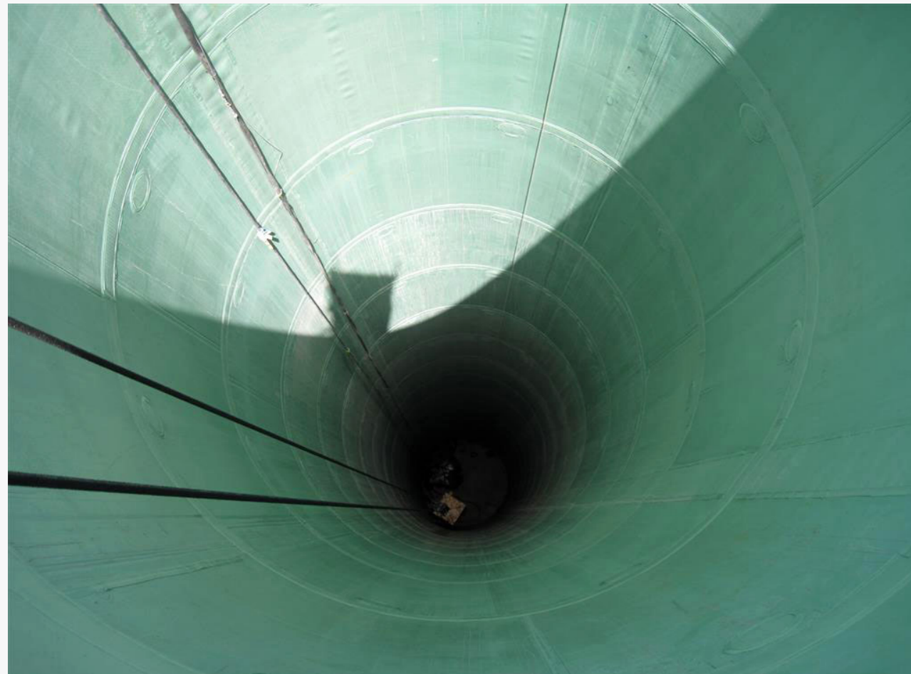
Внутренняя облицовка тоннелей
