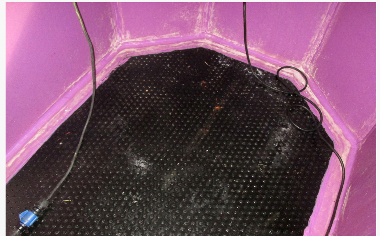
Гидроизоляция заглубленных частей зданий и сооружений
