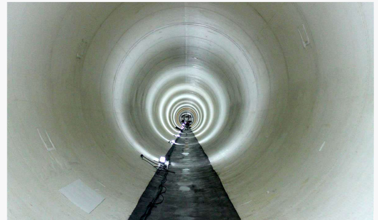
Внутренняя облицовка тоннелей
