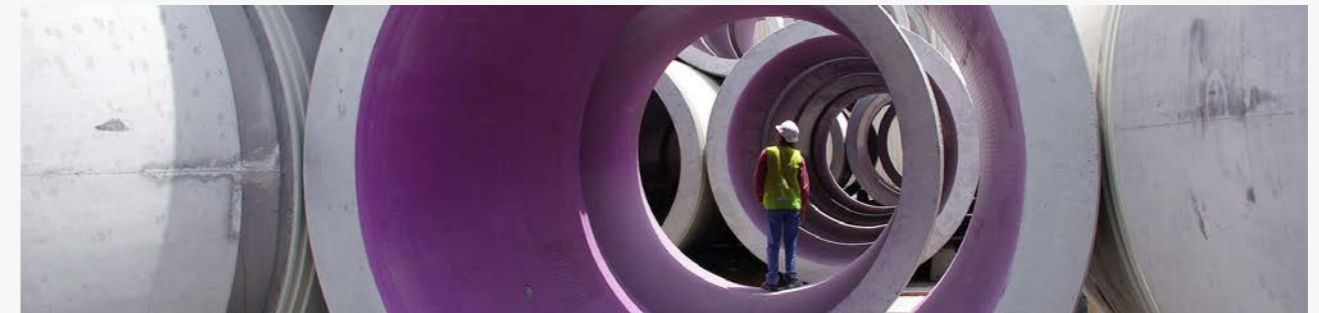
Футеровка внутренних поверхностей бетонных колец
