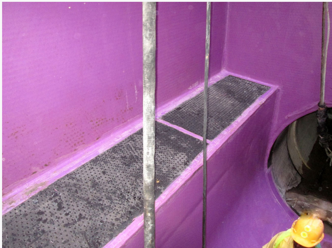
Гидроизоляция заглубленных частей зданий и сооружений
