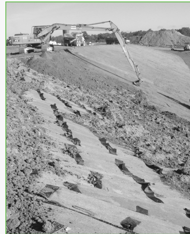
Строительство полигона ТКО
