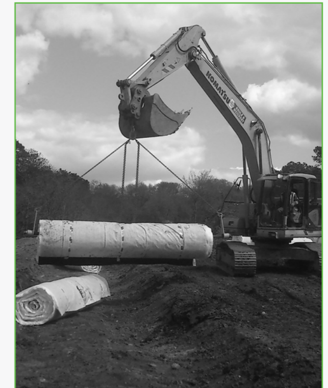
Строительство полигона твердых коммунальных отходов (ТКО)
