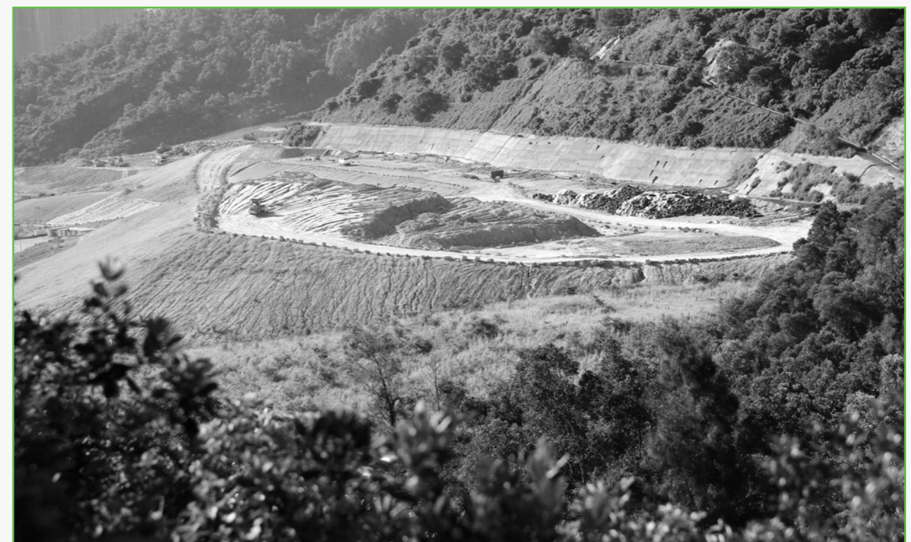
Рекультивация полигона ПО
