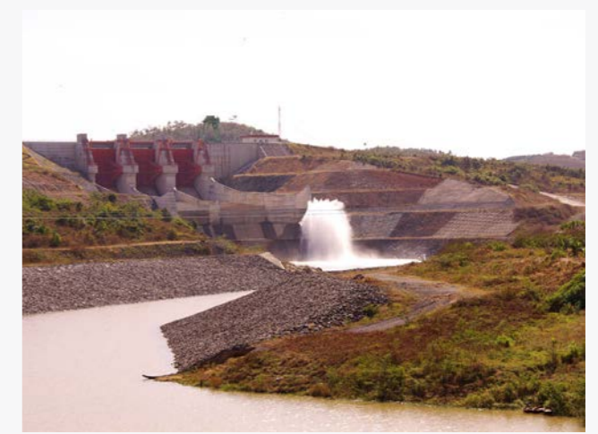
Откосы водоемов, дамб
