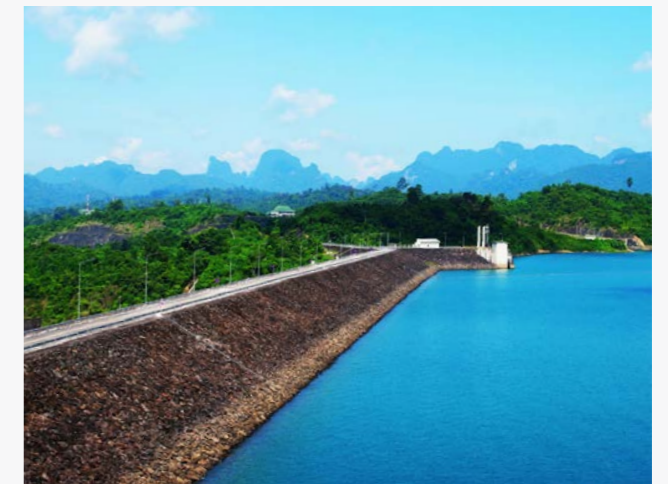
Откосы водоемов, дамб
