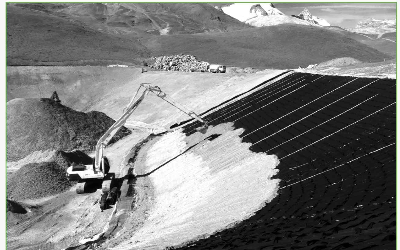
Строительство полигона ПО
