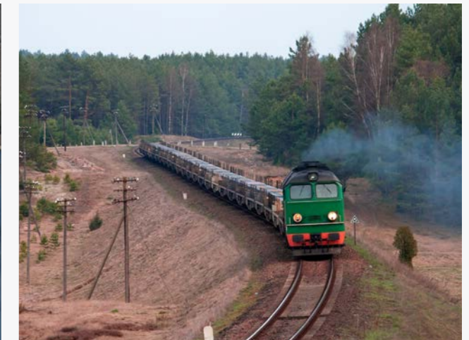
Ж/д пути (насыпи)
