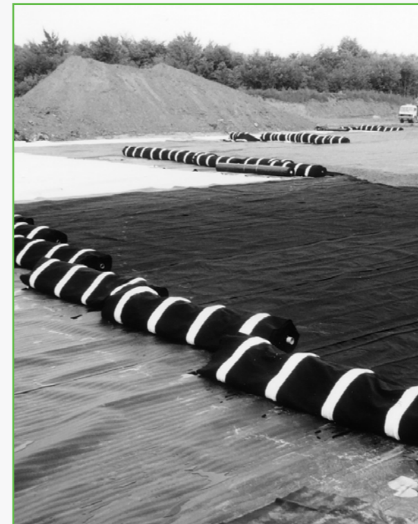
Строительство полигона промышленных отходов (ПО)
