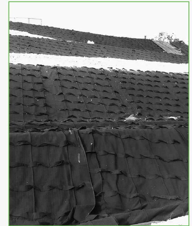
Строительство полигона ТКО
