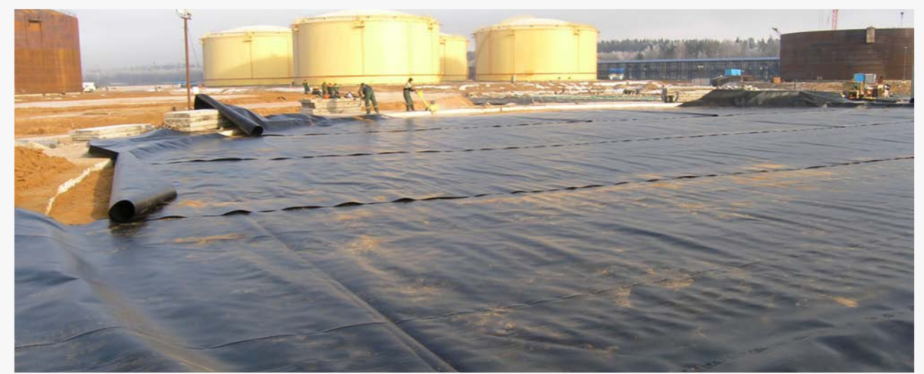
Вторичная изоляция нефтехранилищ и АЗС
