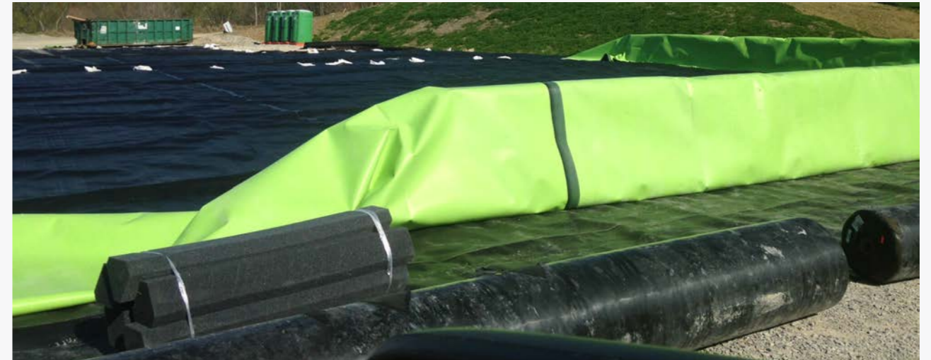
Устройство противofильтрационного барьера с сигнальным слоем
