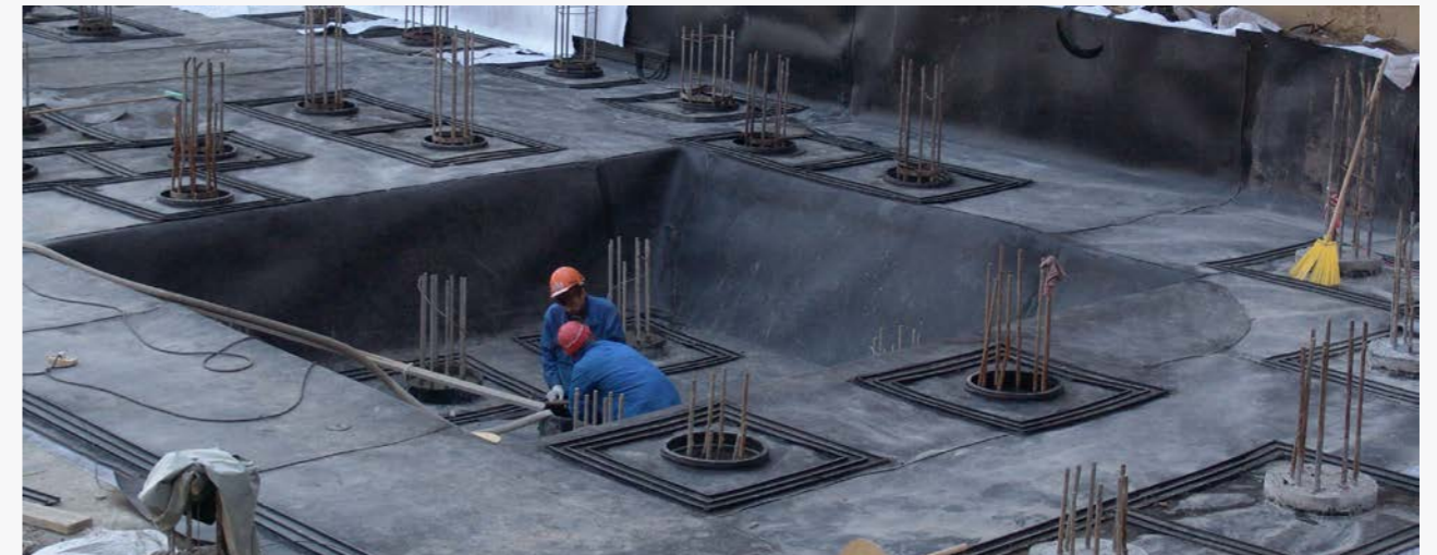
Гидроизоляция подземных и заглубленных сооружений
